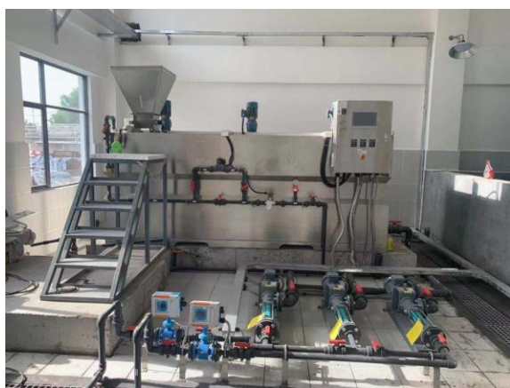
加药设备室内安装
