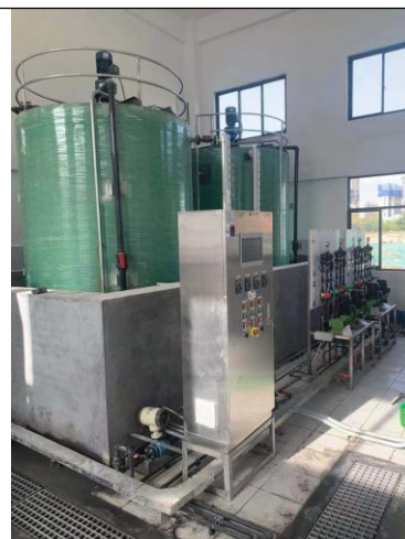
加药设备室内安装
