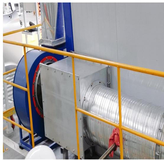
打磨室纤维棉过滤装置
