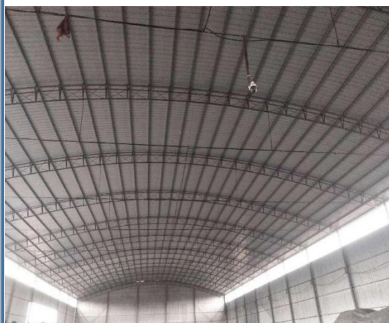
综合车间内喷雾洒水装置
