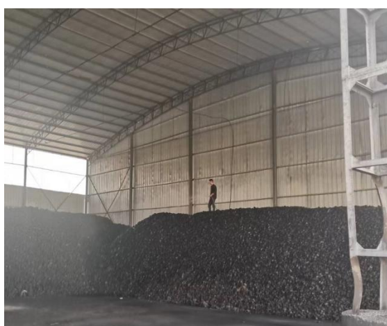
原煤储存人工洒水降尘
