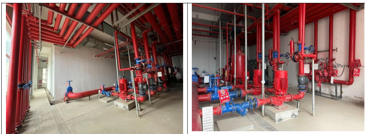
图3-5 消防设施落实情况
