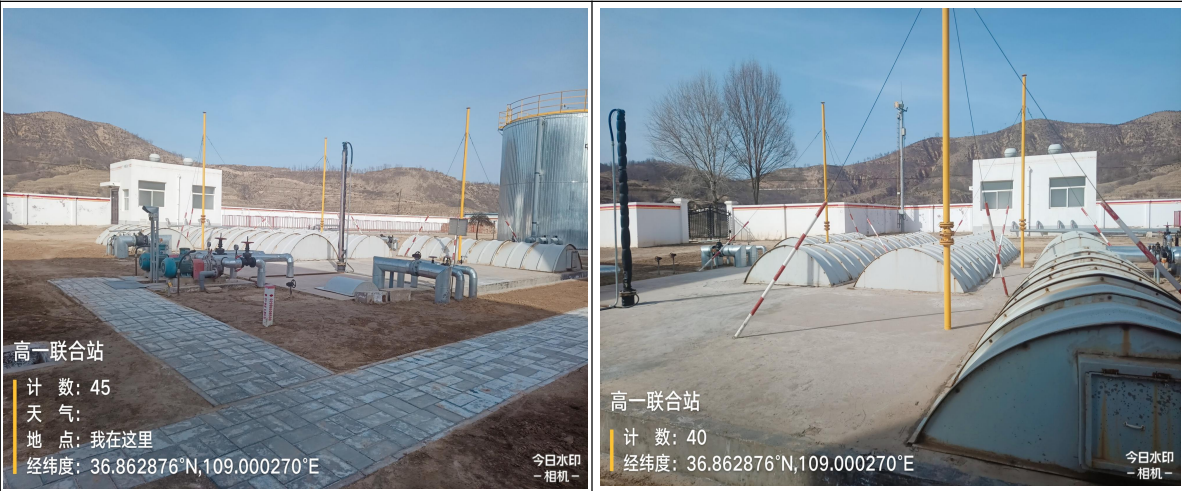
全密闭污水污泥池
