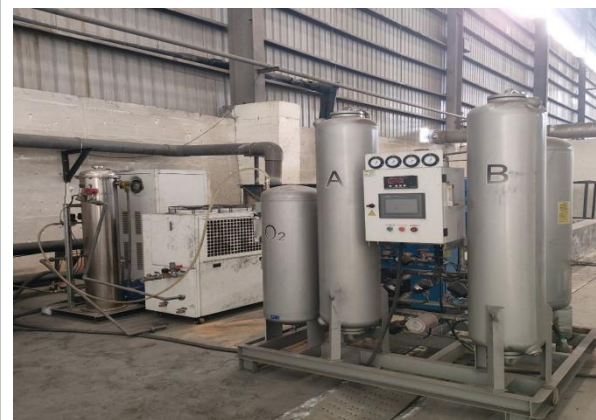
废气治理措施
