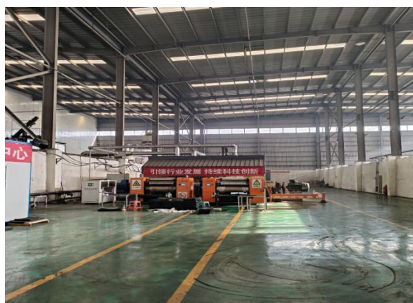
地面防渗措施
